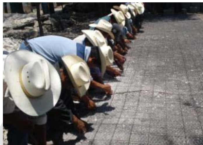
Participación comunitaria en el proceso de tejido de la malla para la construcción de la cisterna
